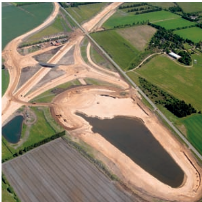
Foto: Motorvejsarbejde ved Høgild
