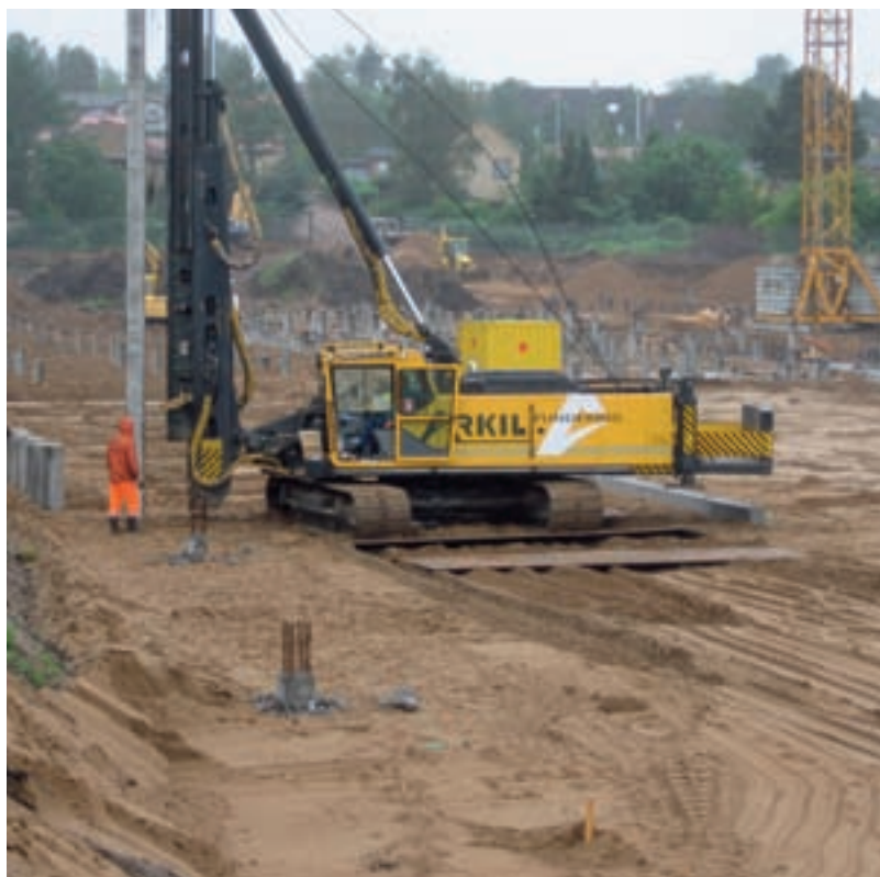
Foto: Ramning af betonpæle
