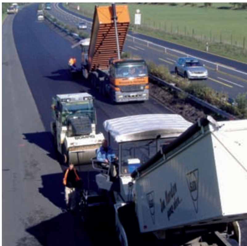
Foto: Asfaltarbejde på motorvej A7, Nordslesvig – SAW
