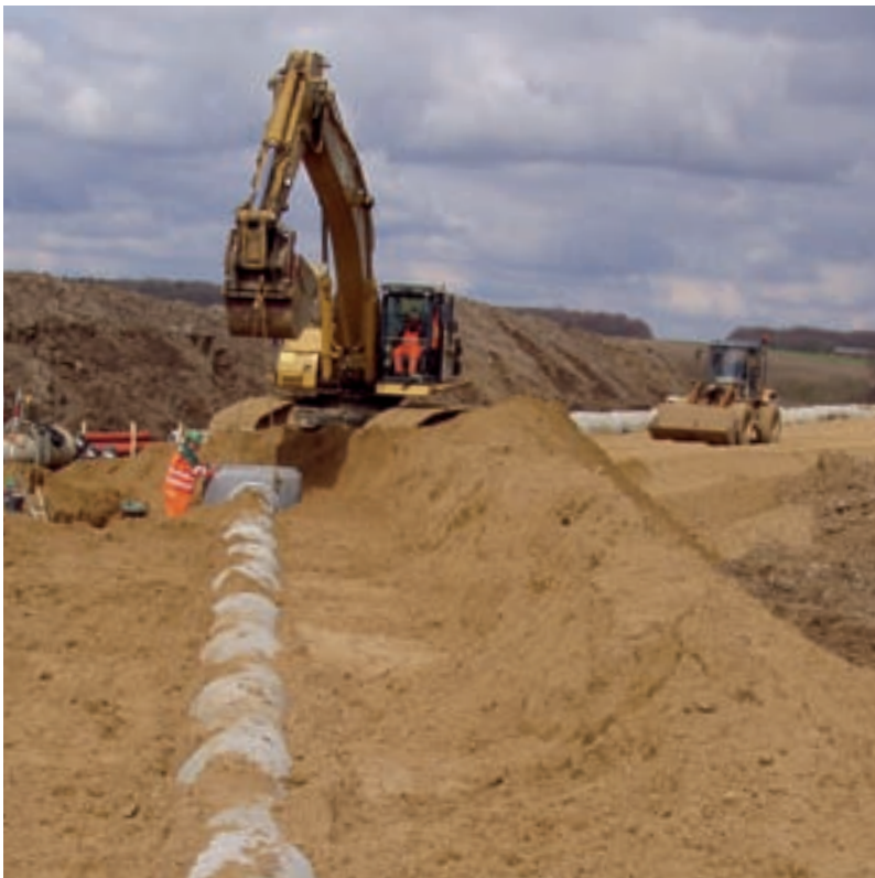
Foto: Omlægning af kloak ved Stilling
