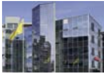
Property: Helsingin Paciuksenkatu 27 Kiinteistö Oy Address: Paciuksenkatu 27, Helsinki Built: 1998
