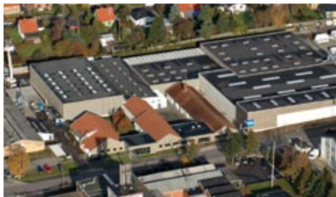
Udvidet og moderniseret RIAS på Industrivej i Roskilde. Oktober 2006.
