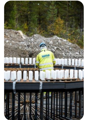
Byggnation av vindpark Jenåsen.
