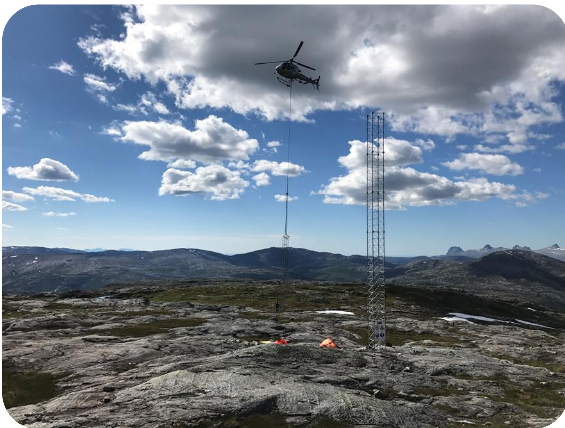
Montering av vindmätmaster på Öyfjellet.
