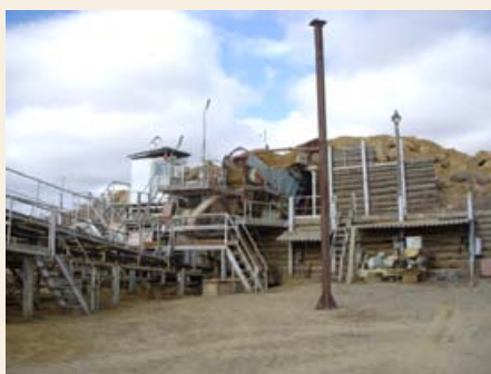
Delar av heap leaching-fabriken hos NMC
