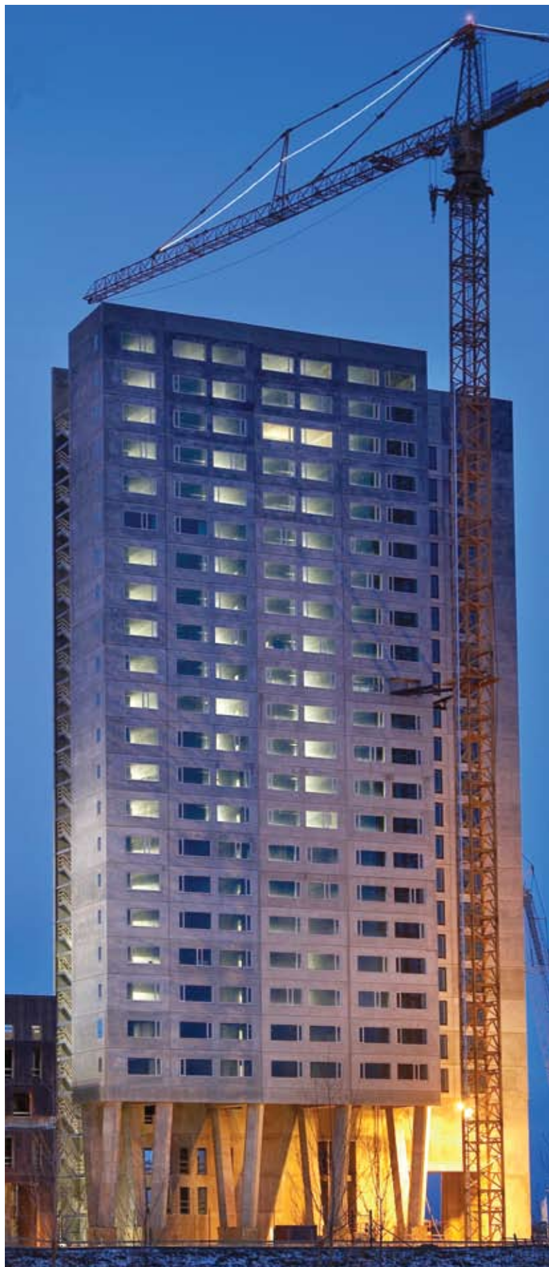
Foto: Copenhagen Towers, råhus etape 1
