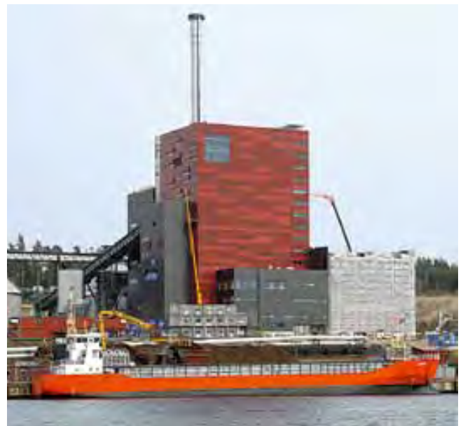
Anläggningsarbeten utförs vid Igelsta Kraftvärmeverk i Södertälje.
