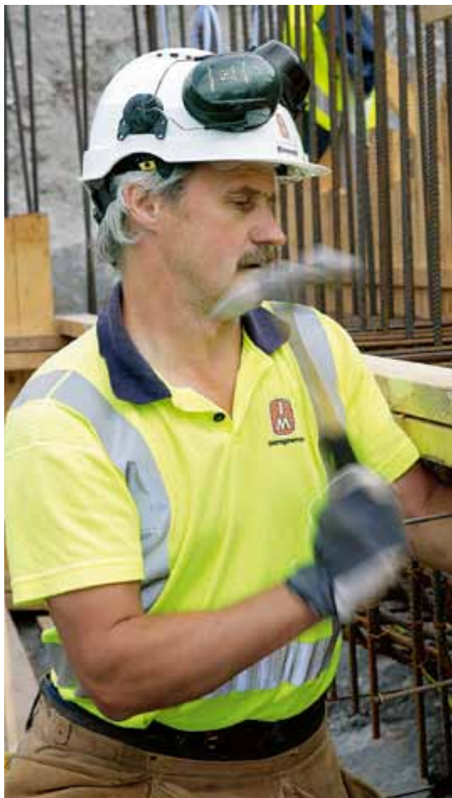
JMs Kurt Jonsson arbetar med formsättning och armering på projektet Kista Terrass i nordvästra Stockholm.
