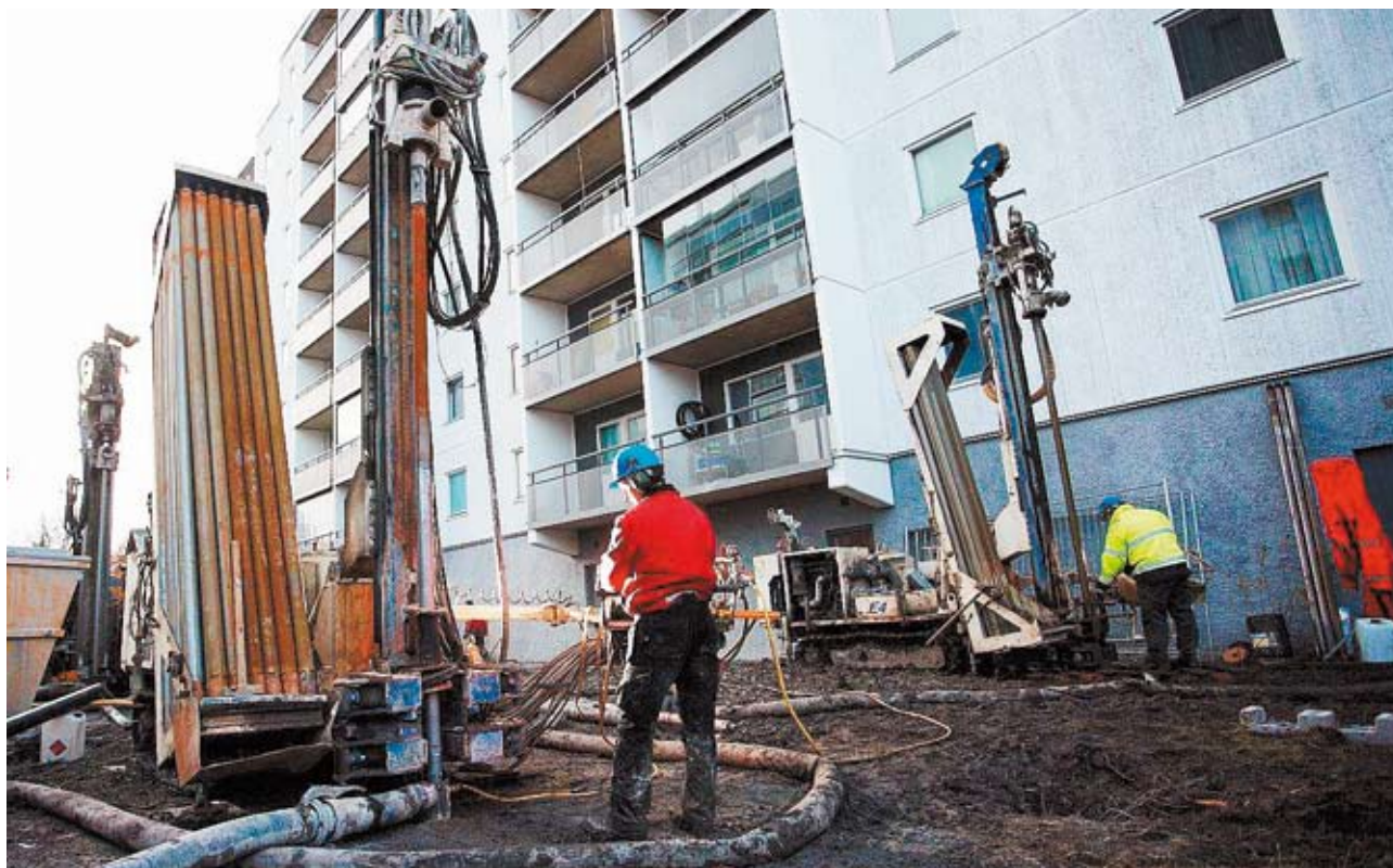
Under 2009 borrade vi för bergvärme i fastigheten Bergen 1 i Husby. Detta tillsammans med andra energieffektiviseringsåtgärder kommer att minska energiåtgången med 80 % i fastigheten.
