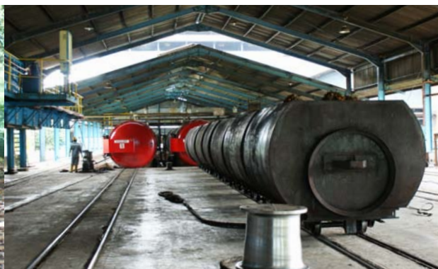
Bunga Tanjung palmoliefabriek (Indonesië)
