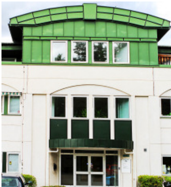
Täby Ventilen 1. I maj tillträdde Klövern fyra fastigheter i Täby. Fastigheterna har bra lägen nära Klöverns befintliga bestånd.
