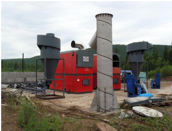
Installation av pannor och träflisanslutning (till vänster), första delarna av torkarna placerade på färdig grund (till höger)
