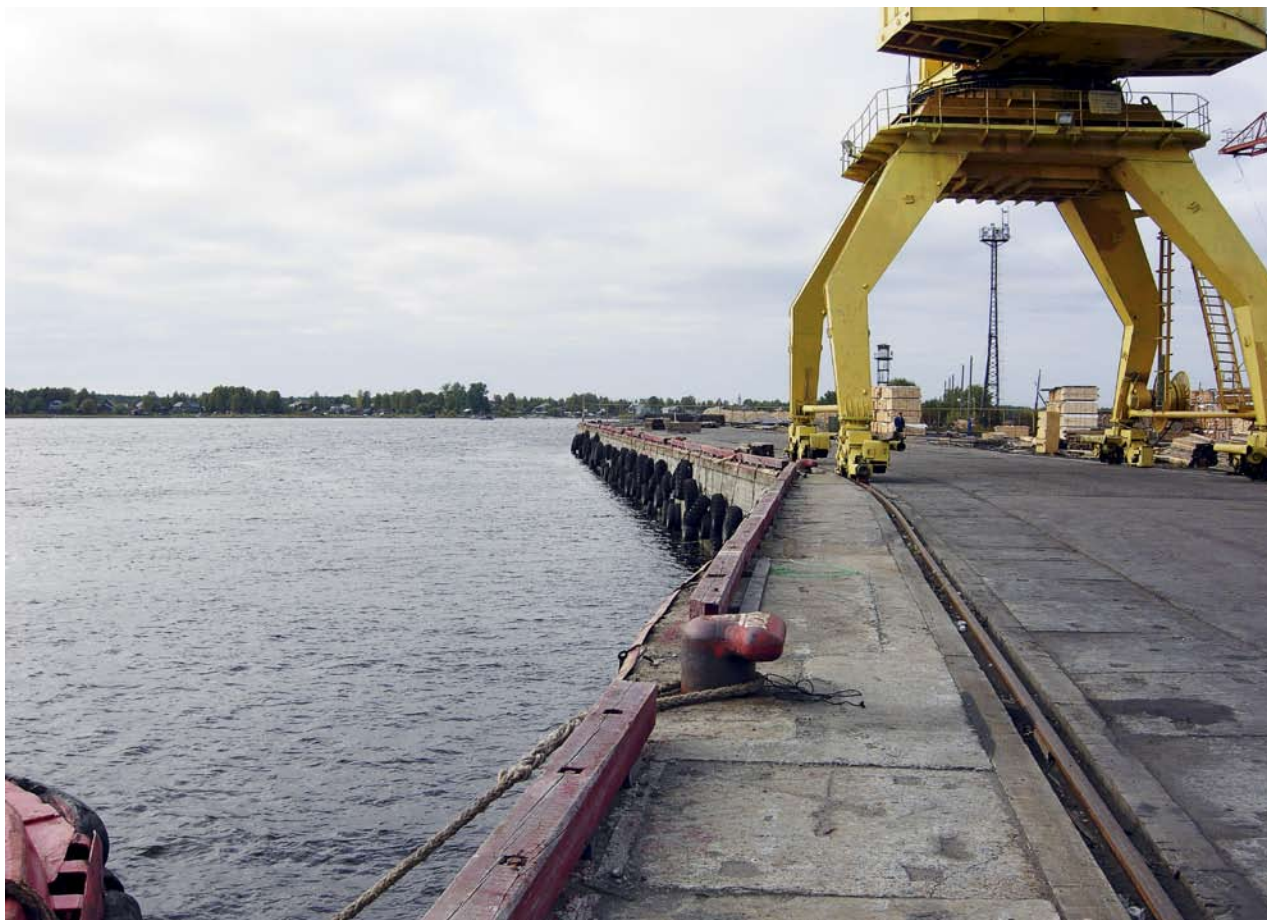
LDK-3: Hamnanläggning, 253 meter lång med 10 meters djup
