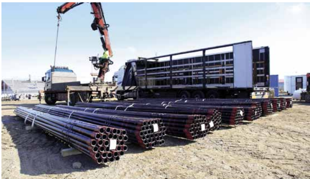
Olierør aflæsses for indvendig coating
