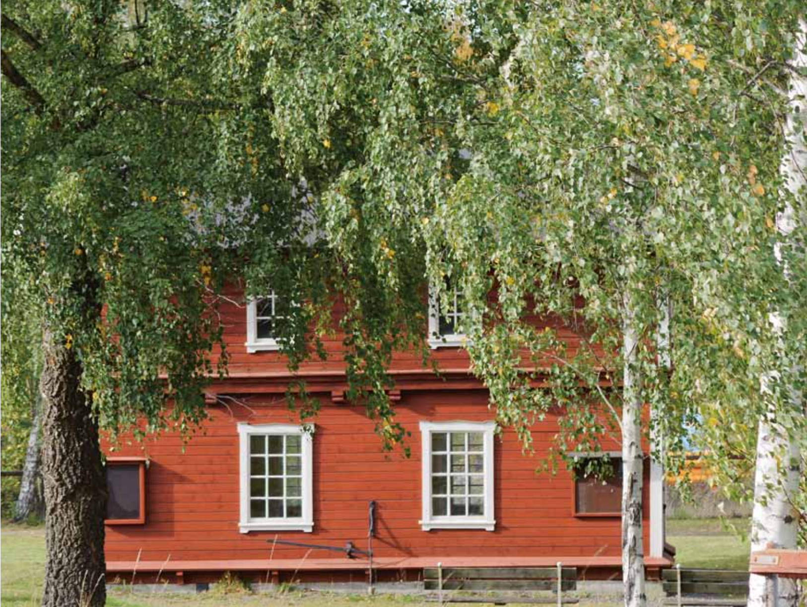
Det gamla pumphuset vid Storrymningen.
