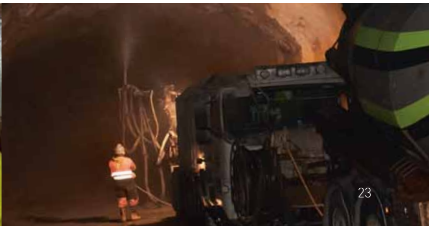
Orttaket betongsprutas för att öka säkerheten.
