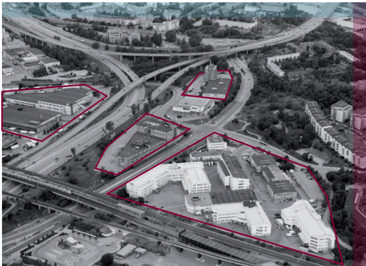
Vid infarten till Stockholm, där Essingeleden (E4/E20) möter Södra länken, ligger Sagax fastighet Varubalen 3 med närhet till spårbunden trafik som pendeltåg och tvärbana. På bilden syns även fastigheterna Lagerhuset 3, Lagret 1, Packrummet 9, Packrummet 10, Packrummet 11, Packrummet 12 och Varuhissen 1 vilka ägs av Sagax intressebolag Söderport.
