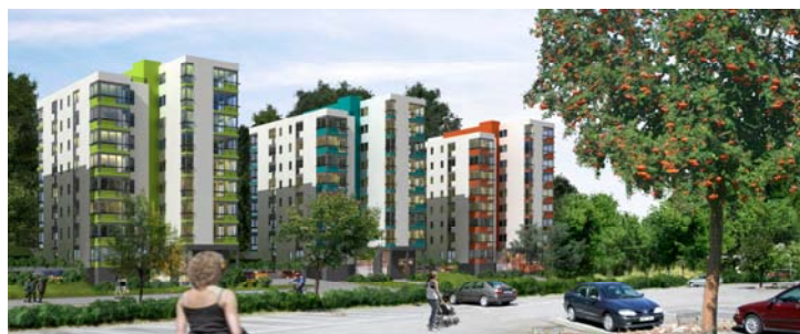
I Wallenstams energieffektiva nybyggnation i Högsbo kommer hyresgästerna att själva kunna påverka förbrukning och kostnad för vatten och el tack vare individuell mätning.
