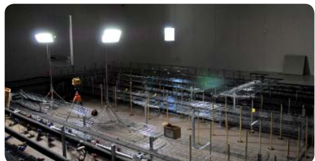
Byggnation av el- och kylsystem i Phoneras datacenter i Linköping.
