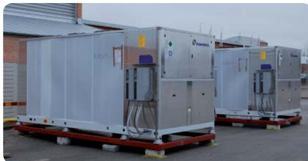
Leverans av vätskekylaggregat som ska producera kyla i anläggningen.
