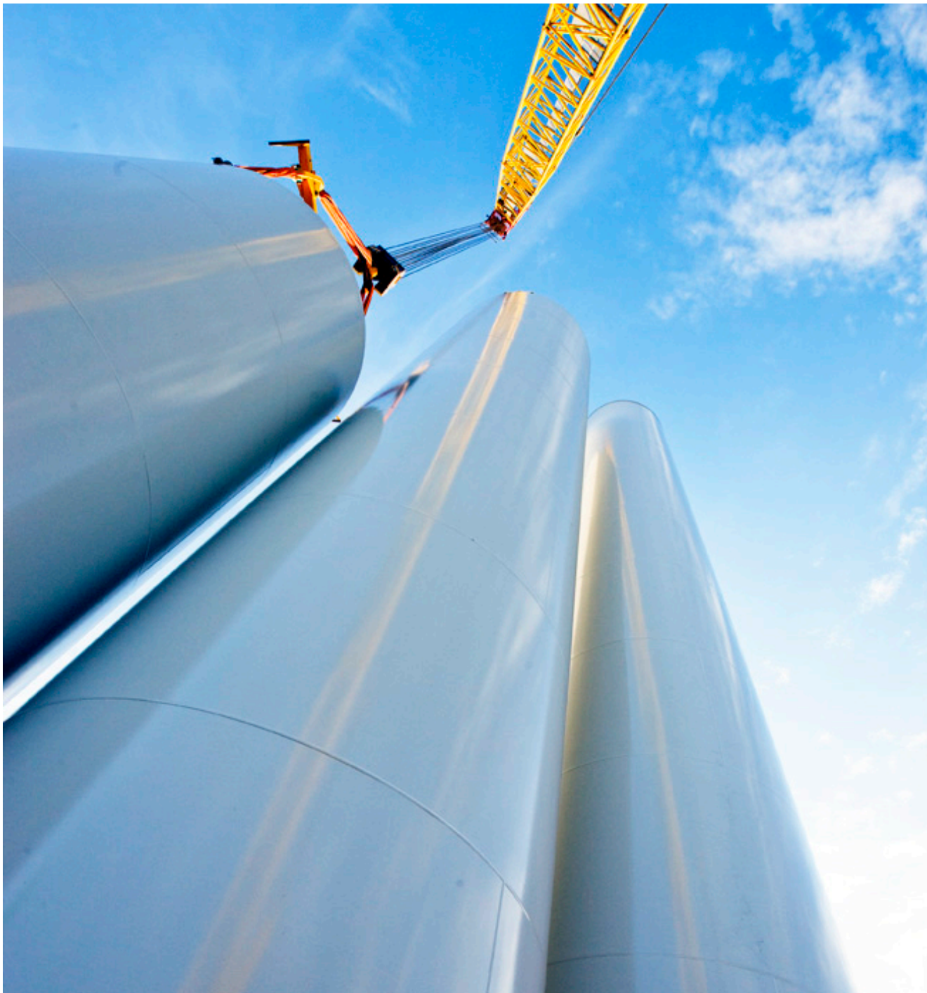
Resning av torn till Vindpark Vänern i april 2009.
