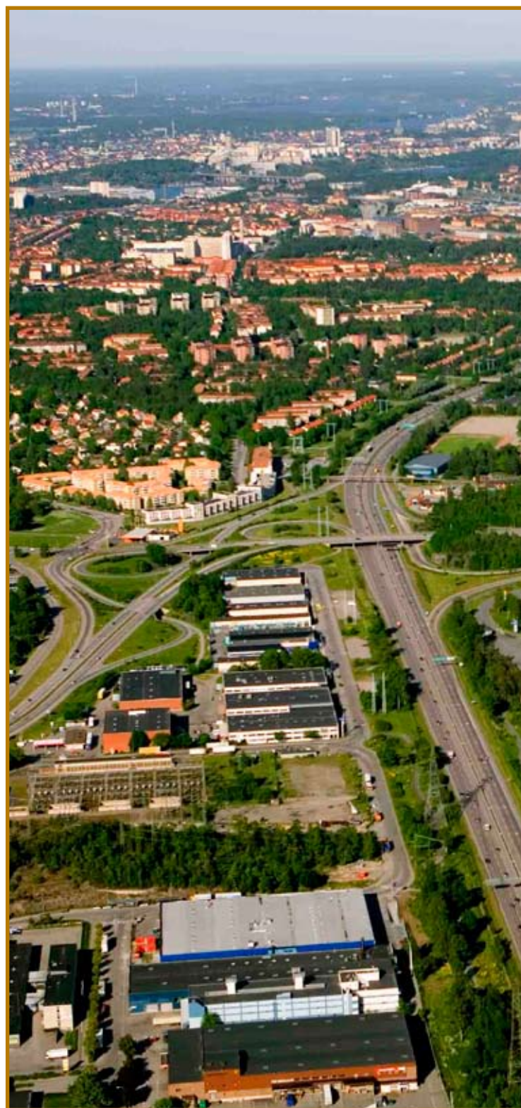
Sagax fastigheter Stensättra 16 och Murmästare-Ämbetet 3 i Stockholms stad ligger invid E4.
