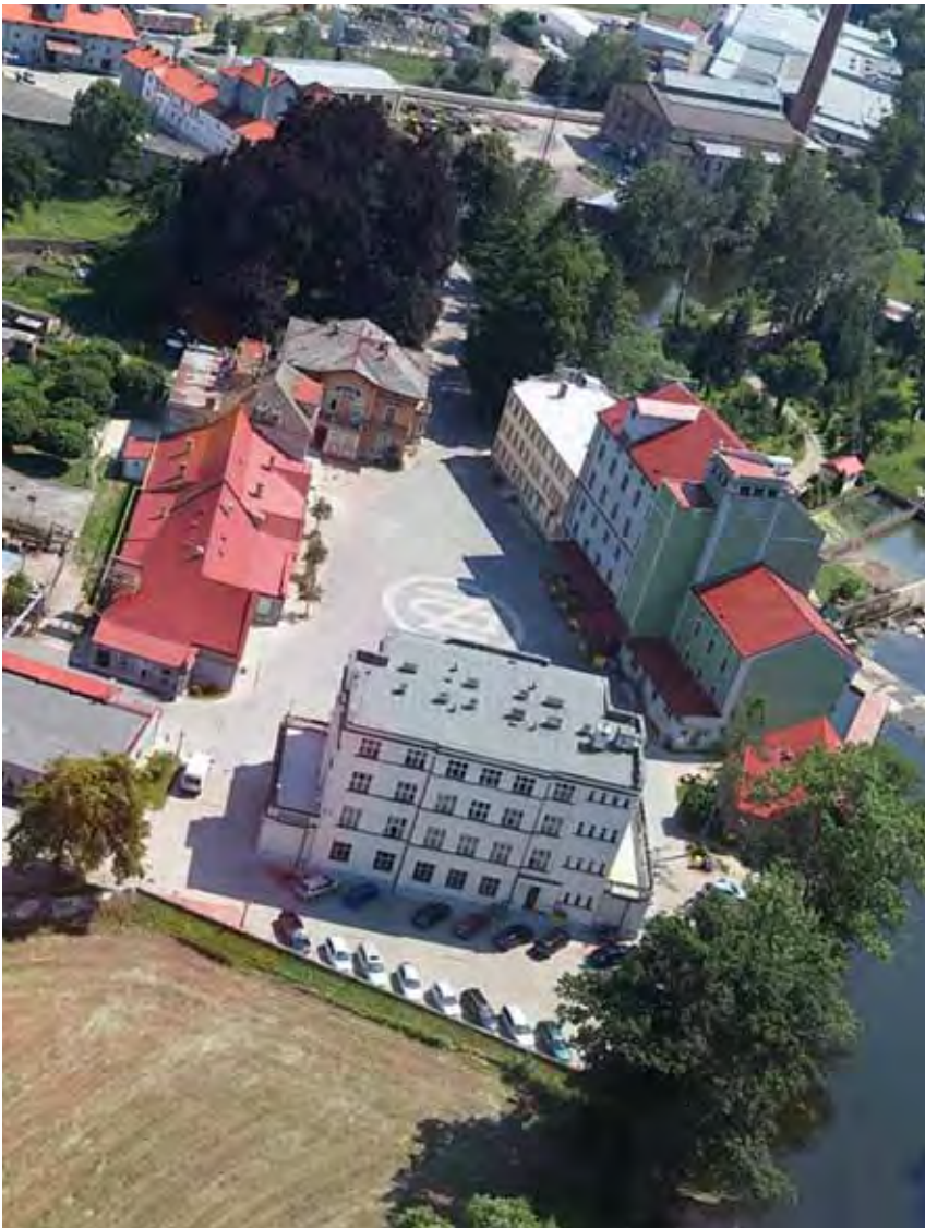
I tjeckiska DZ Drazice, vars huvudkontor och lagerbyggnader syns på bilden, genomförs kontinuerliga investeringar för kostnadseffektiv produktion, senast i en ny rationell anläggning avsedd för tillverkning av större ackumulatörer av varmvatten.
