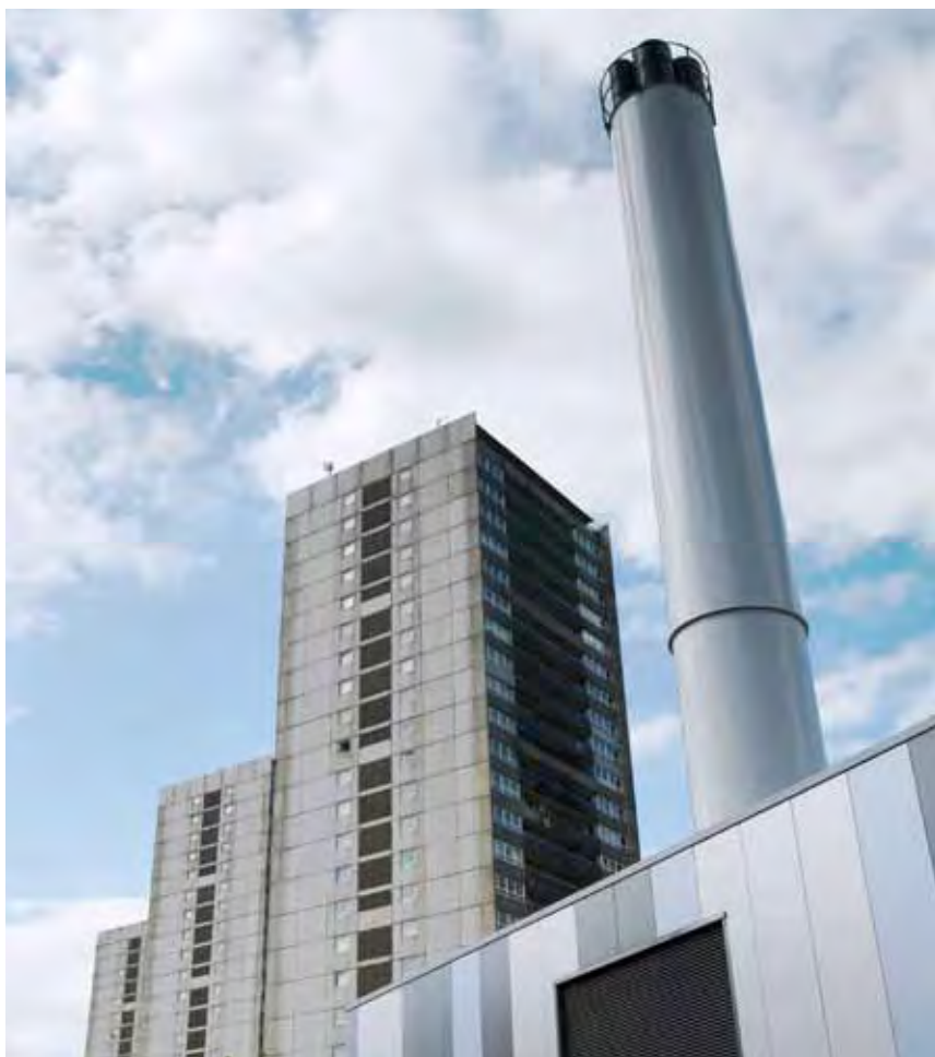
Danska KVM har levererat fjärrvärmeenheter till ett mycket stort projekt i Wyndford, Skottland när bostadsområdet, som uppfördes under 1960-talet och omfattar över 1.500 lägenheter, konverterades från direkt eluppvärmning till fjärrvärme. Nu ser de boende i Wyndford fram emot både lägre uppvärmningskostnader och mindre miljöbelastning genom de kraftigt minskade CO 2 -utsläppen.
