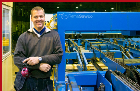
Installation av RS-Boardscanner hos kund. RemaSawcos projektledare Urban Ståhl.
