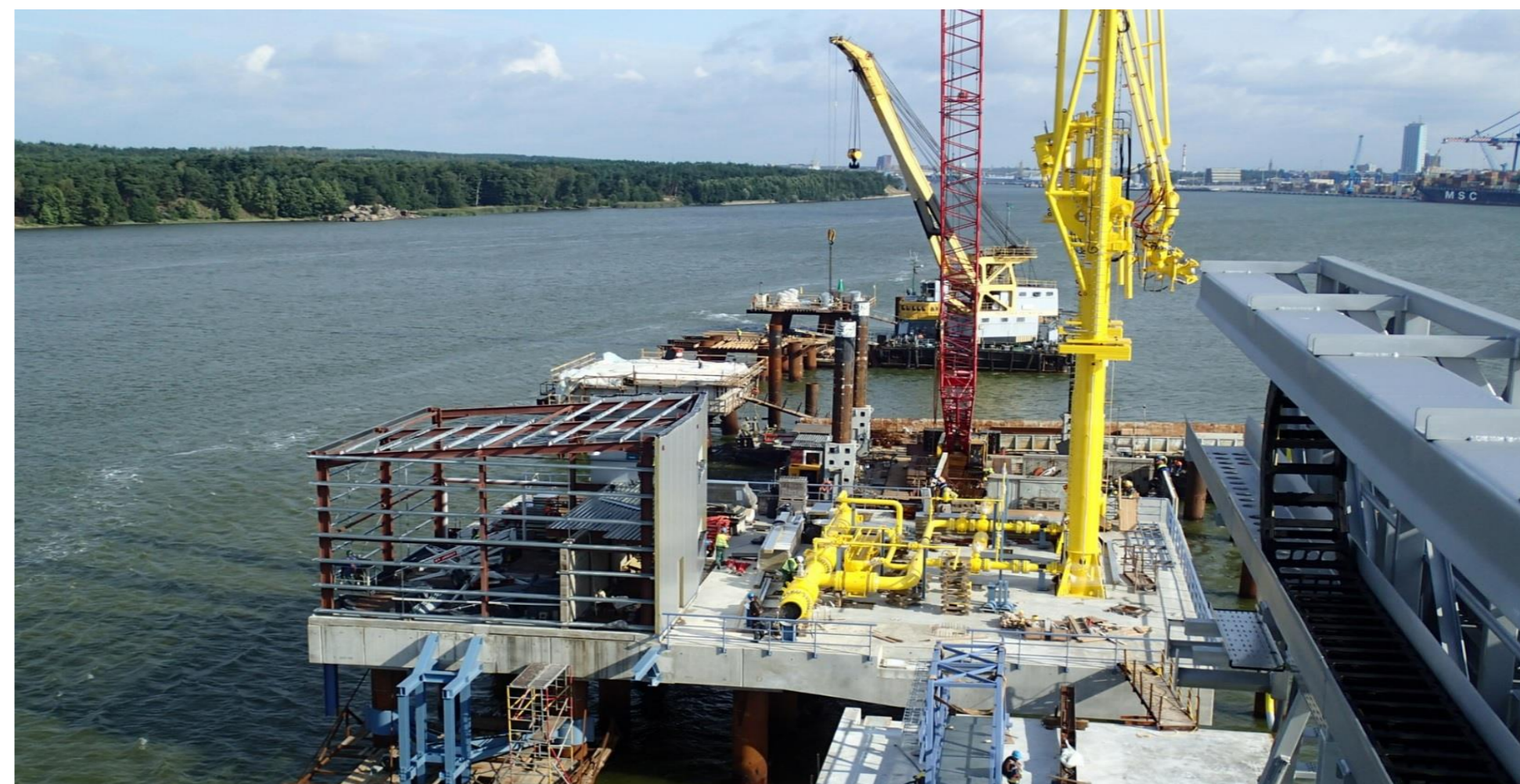
Krantinės platformų statybų darbai
