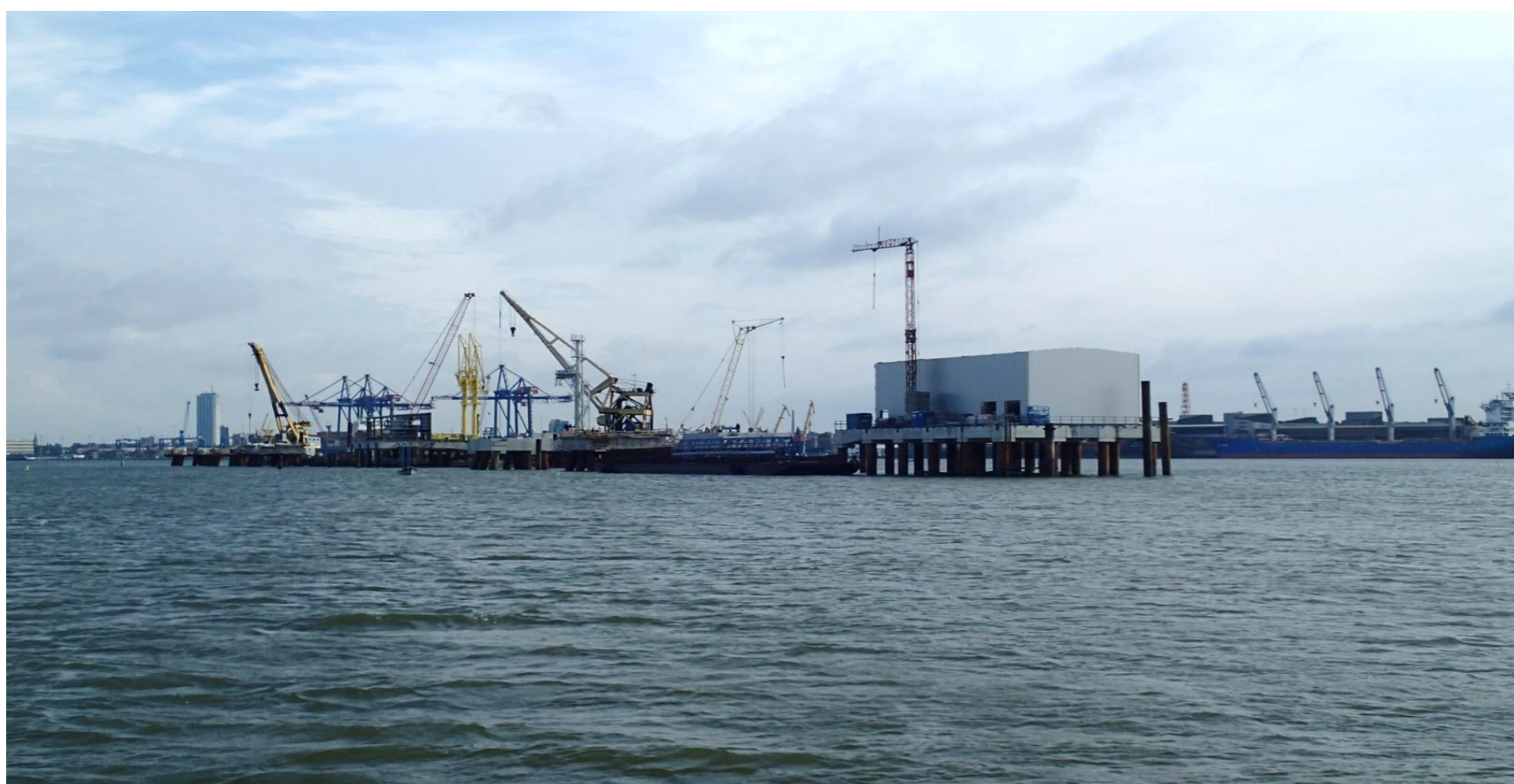
Krantinės platformų betonavimo darbai
