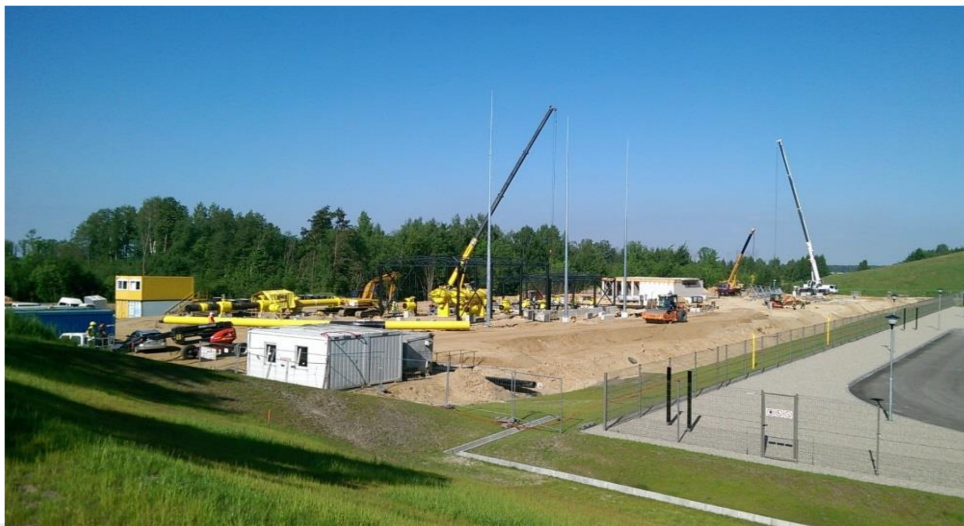
Dujų apskaitos stoties statybos
