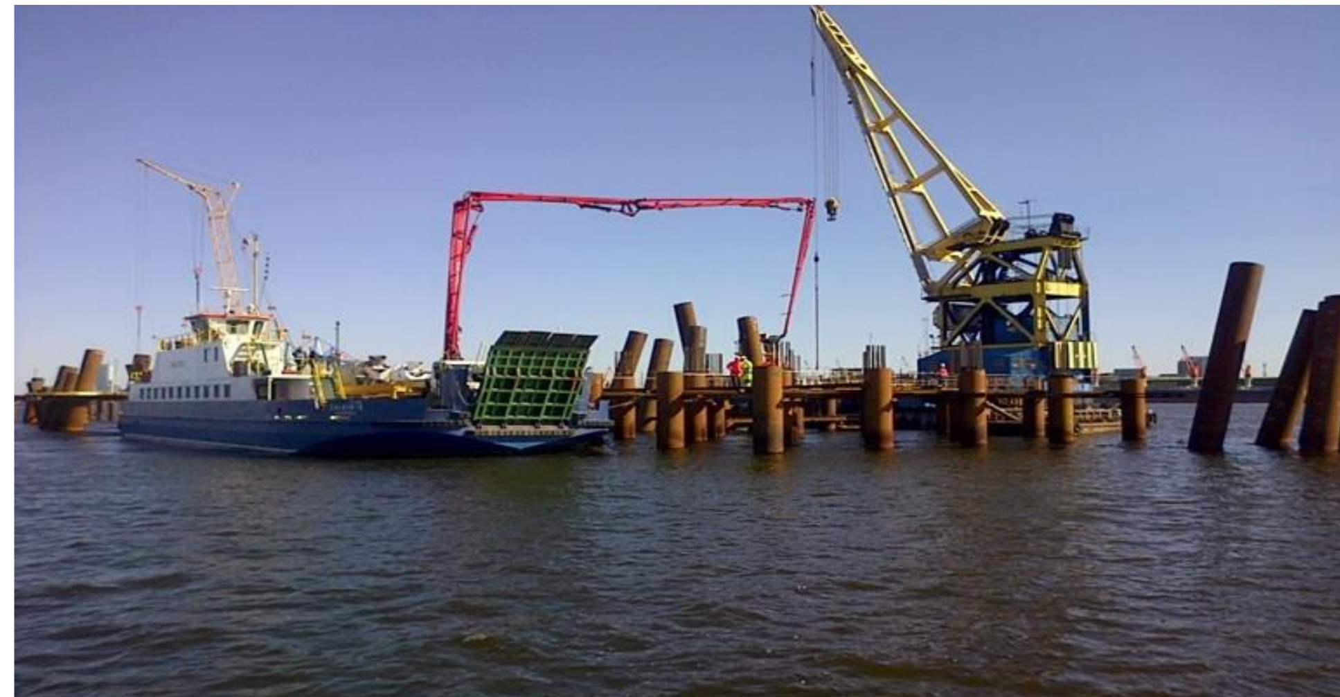
Polių betonavimo darbai
