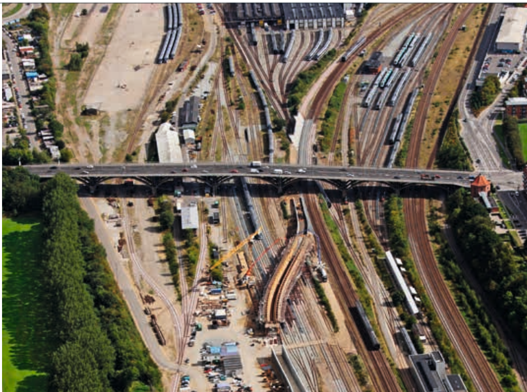
I banegraven vest for Aarhus Hovedbanegård udfører Aarsleff en 125 meter lang bro, som fører byens kommende letbane hen over seks jernbanespor.
