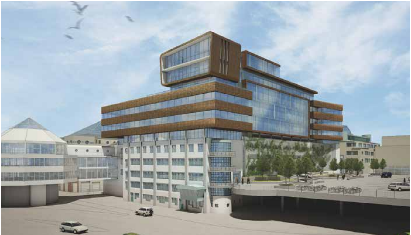
På Knutpunkten i Helsingborg genomför Wihlborgs en påbyggnad med cirka 8 000 m 2 moderna kontorslokaler. Totalt skapas 500–600 nya kontorsarbetsplatser ovanpå den befintliga fastigheten. Tyréns har tecknat sig för ett helt våningsplan och de första hyresgästerna beräknas kunna flytta in under första kvartalet 2016.
