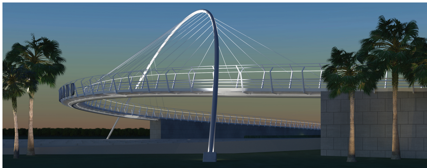
Interstate 4 Ultimate, Florida, USA.
