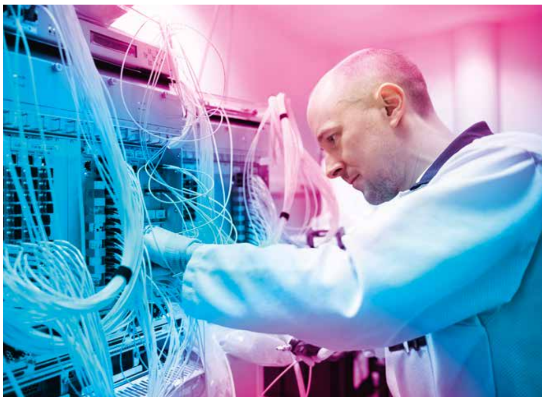
Pre-Staging, innebär att utrustning förmonteras och konfigureras före leverans, vilket leder till en snabbare och enklare installation hos kunden.
