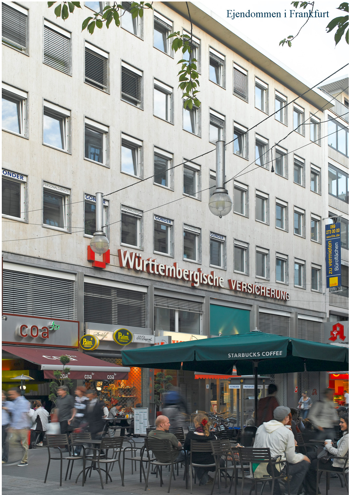
Ejendommen på Schillerstrasse med flere små butikslejere. De øvrige etager er kontolejemål.
