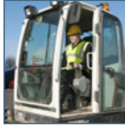
Bo Annvik tar första spadtaget för nya FoU-anläggningen på MIRA i England.
