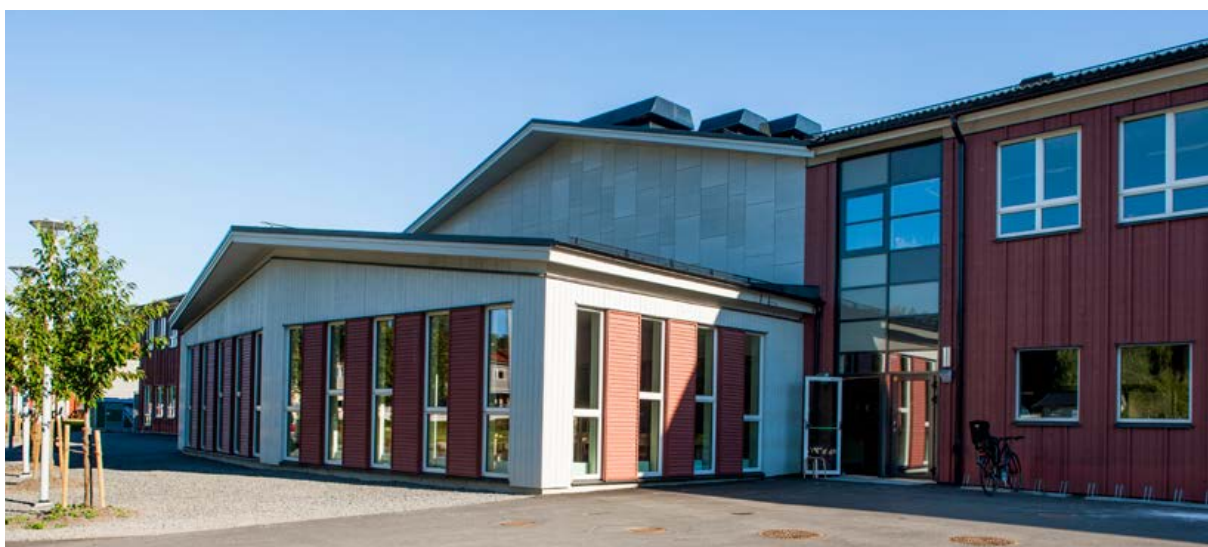
Vendelsö 3:1986 Vendelsö, är ett så kallat passivhus som värms upp av solen, interna värmevinster och återvunnen värme i ventilationssystem
