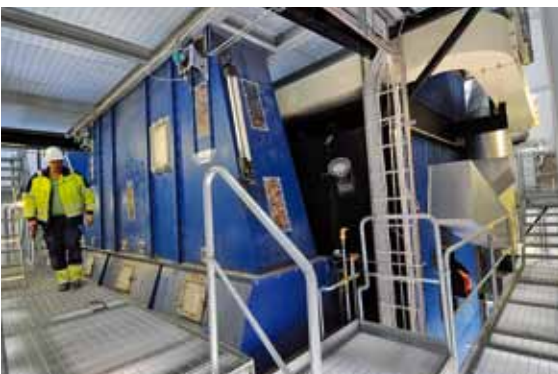
En Saxlundugn i en biobränsleanläggning.
