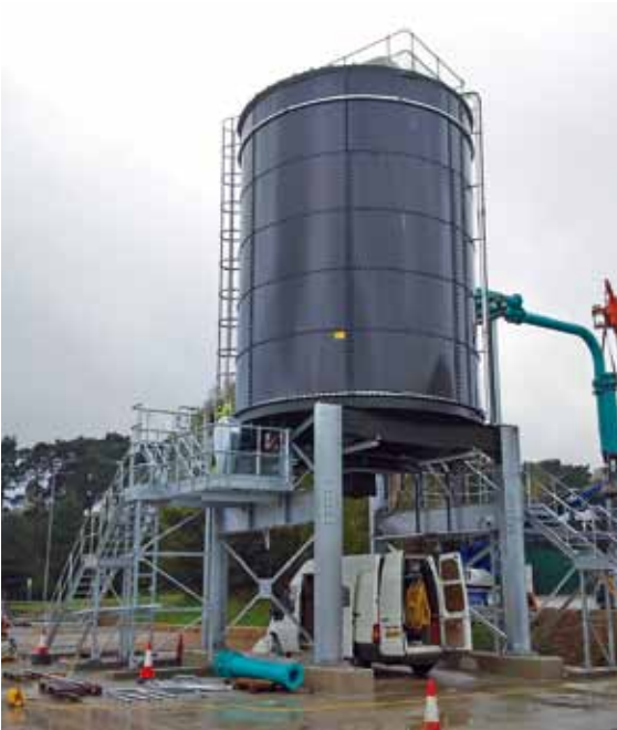
Silo för lagring och transport av slam i ett reningsverk, levererad av Saxlund International i Storbritannien.
