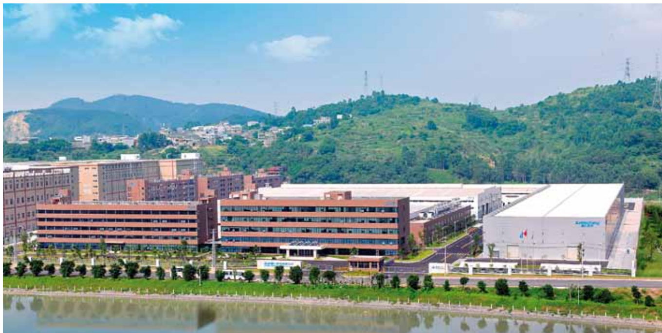
Huvudanläggningen för kylteknikföretaget Snowman i Fuzhou, Kina, med den nya fabriken för tillverkning av kompressorer som utvecklas av Opcon.
