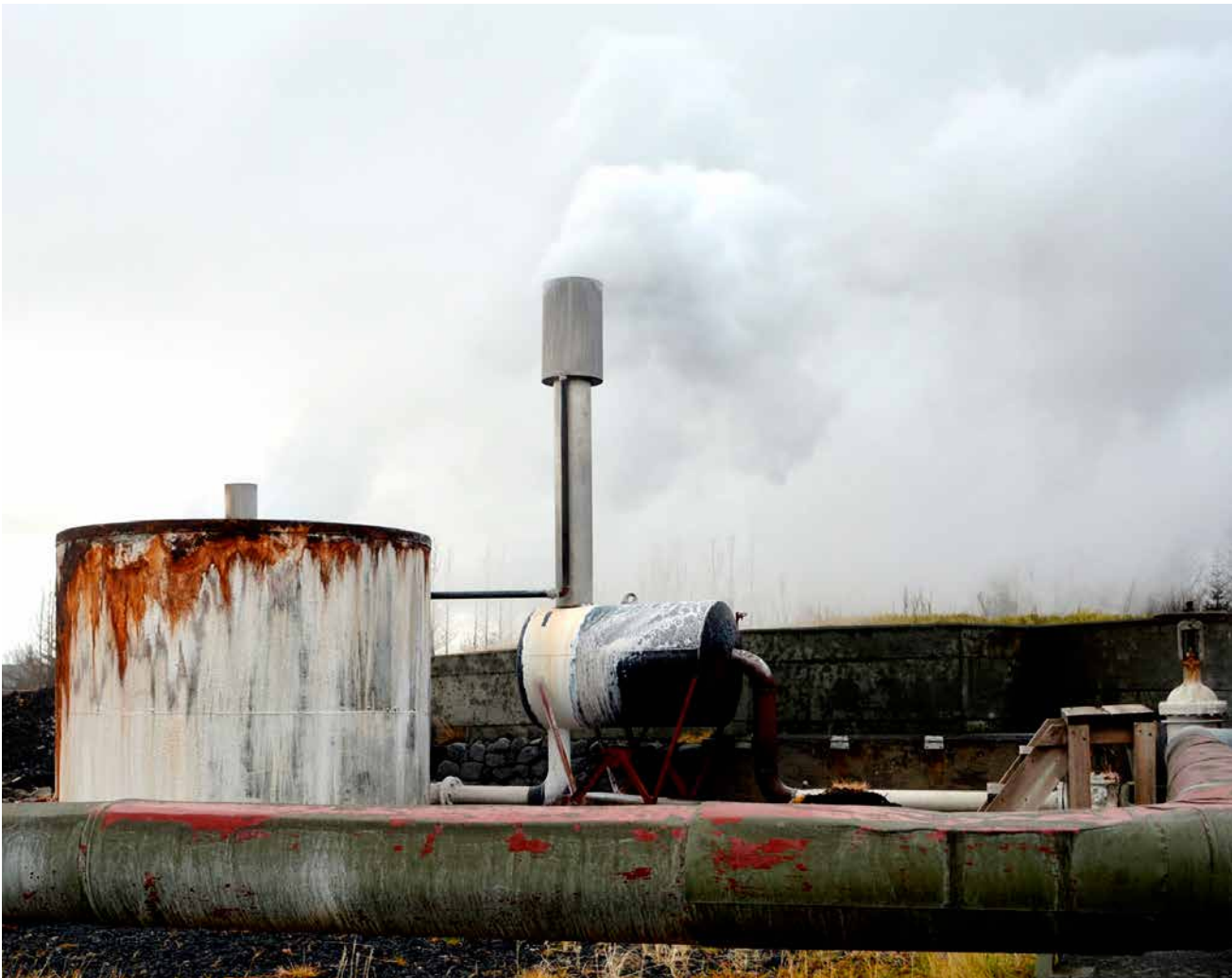
Mynd 39. Hljóðdeyfir og gufuháfur í Hveragerði. Ljósmynd: Bjarni Lindal.
