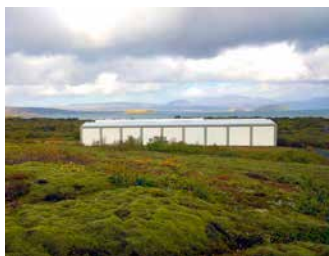
Mynd 6. Dælustöð á Grámel við Nesjavelli sem er afkastamesta vatnsból landsins. Ljósmynd: Magnea Magnúsdóttir.
