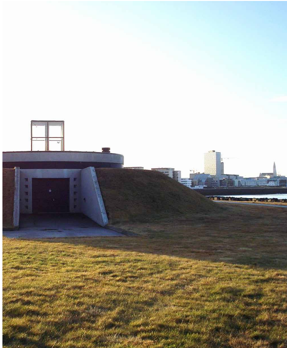
Mynd 13. Dælustöð við Laugalæk. Ljósmynd: Þorsteinn Ari Þorgeirsson.
