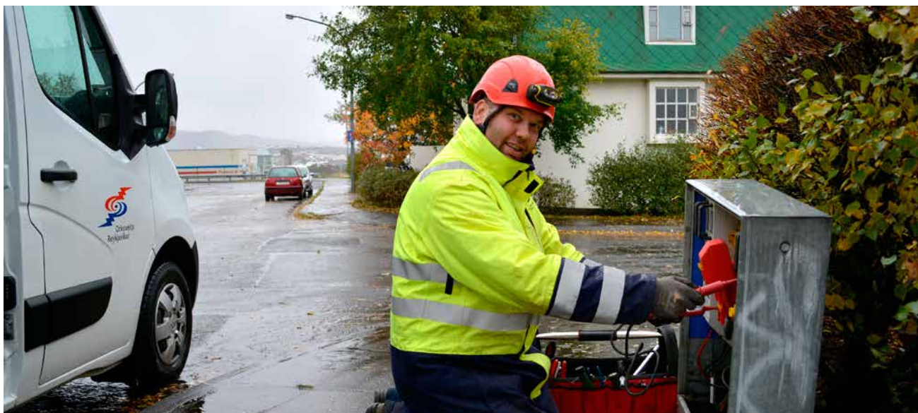
Mynd 1. Unnið að tengingum í götuskáp. Ljósmynd: Bjarni Líndal.
