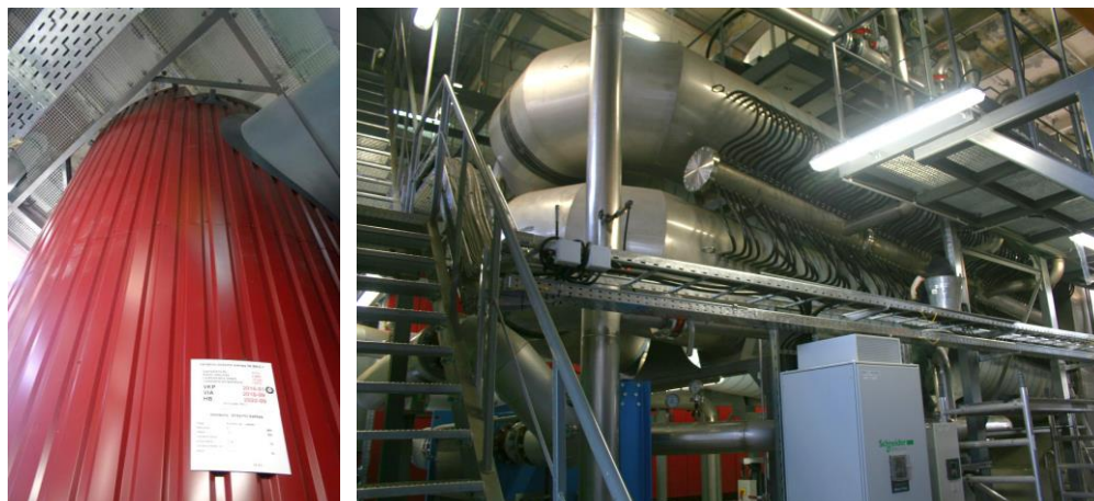
Nuotr.: naujasis vandens šildymo katilas ir kondensacinis ekonomaizeris „Šilko“ katilinėje
