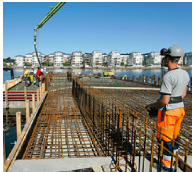
Exploateringsarbete i Henriksdalshamnen i Hammarby Sjöstad, Stockholm.
