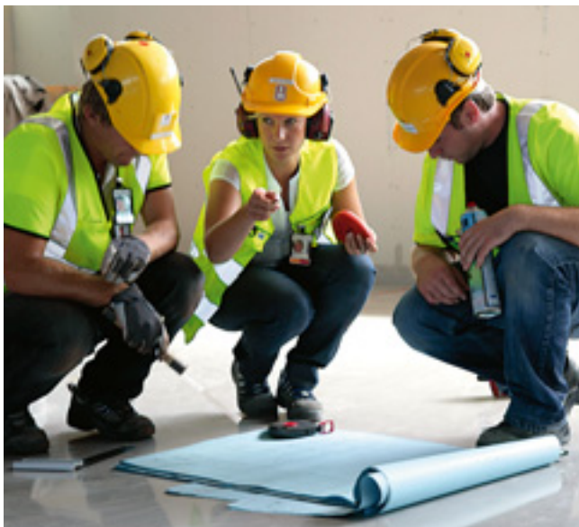
Utbyggnad av centralbyggnaden på Arlanda flygplats.
