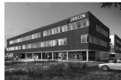
Construction of head office Orbicon Høje Tåstrup
