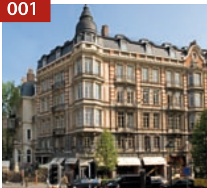
Avenue de Tervueren 13 A/B Avenue des Celtes 4-10 1040 BRUXELLES
