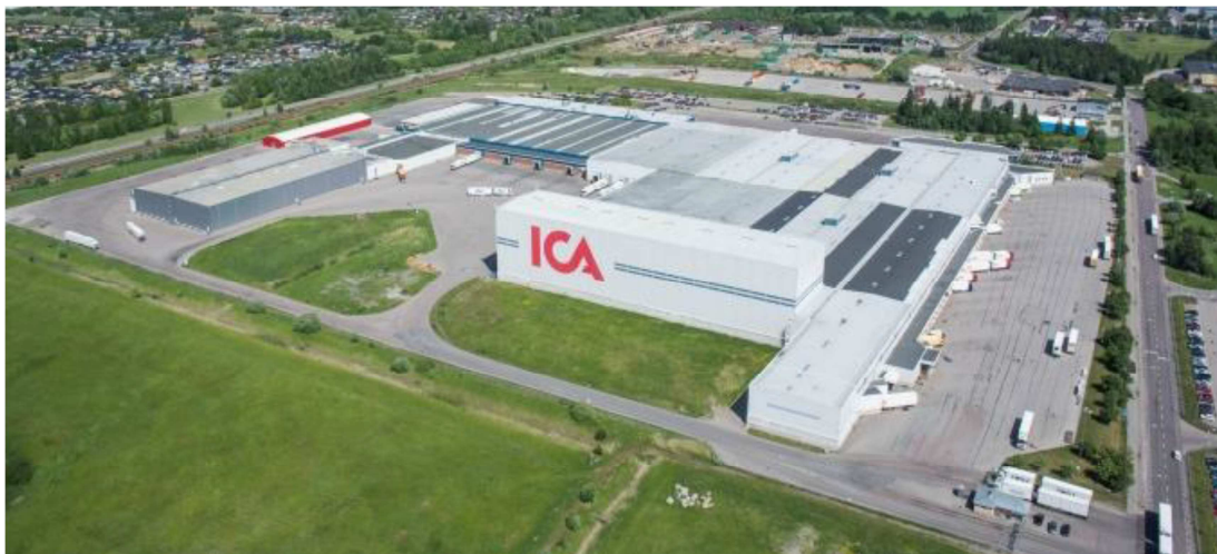
Fastigheten Saltängen 1 i Västerås förvärvades i december 2014.
