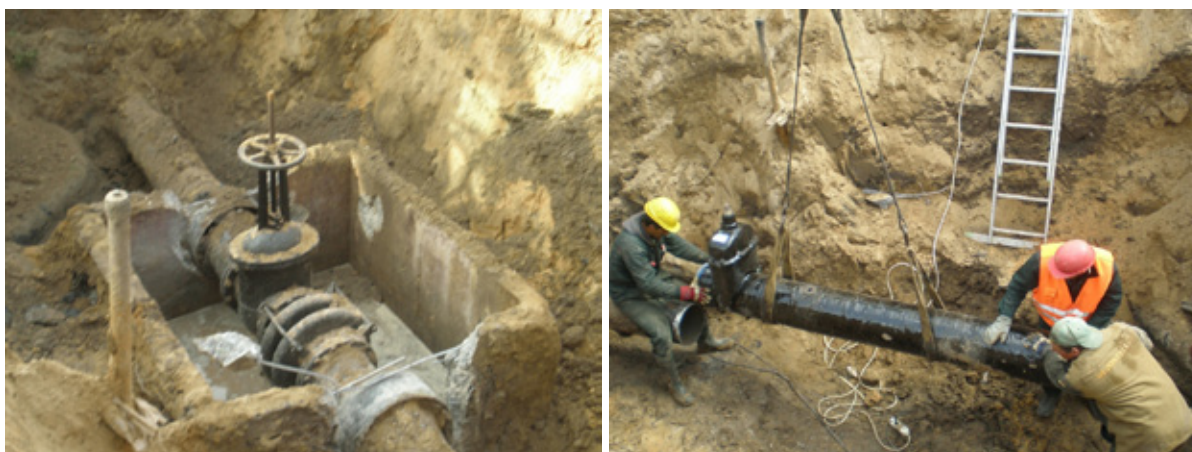
24 paveikslas. Senų uždarymo sklendžių keitimas naujomis.
