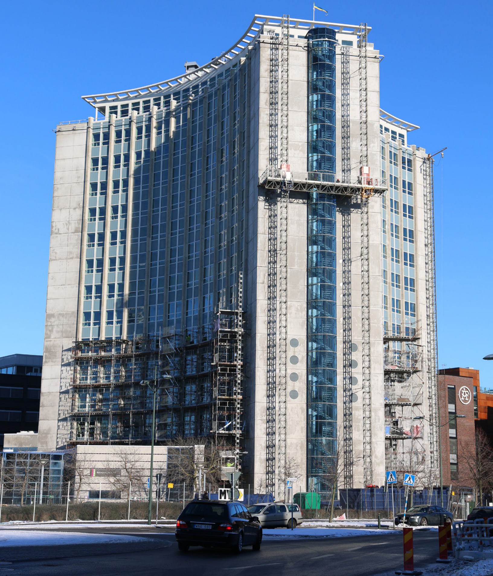
December 2015, nu börjar man ana den nya fasaden på Gångtappen 1. Länsförsäkringar flyttar in i de 6 översta våningarna sommaren 2016.
