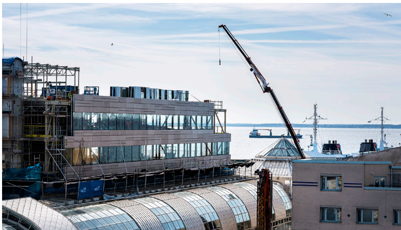
Påbyggnaden på Knutpunkten i Helsingborg växer fram. De 8 000 m 2 är inflyttningsklara våren 2016. Hit kommer även vårt Helsingborgskontor att flytta.
