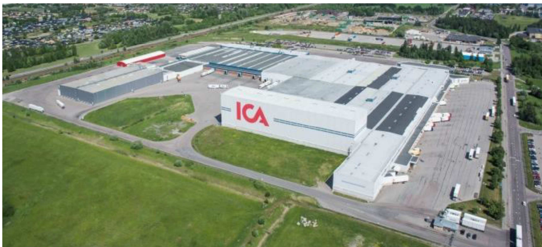
Fastigheten Saltängen 1 i Västerås förvärvades i december 2014.
