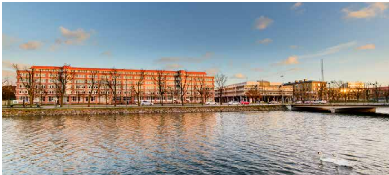
På andra sidan kanalen skymtas Drottninggatan med fastigheterna Nora 11 och Karin 11.
