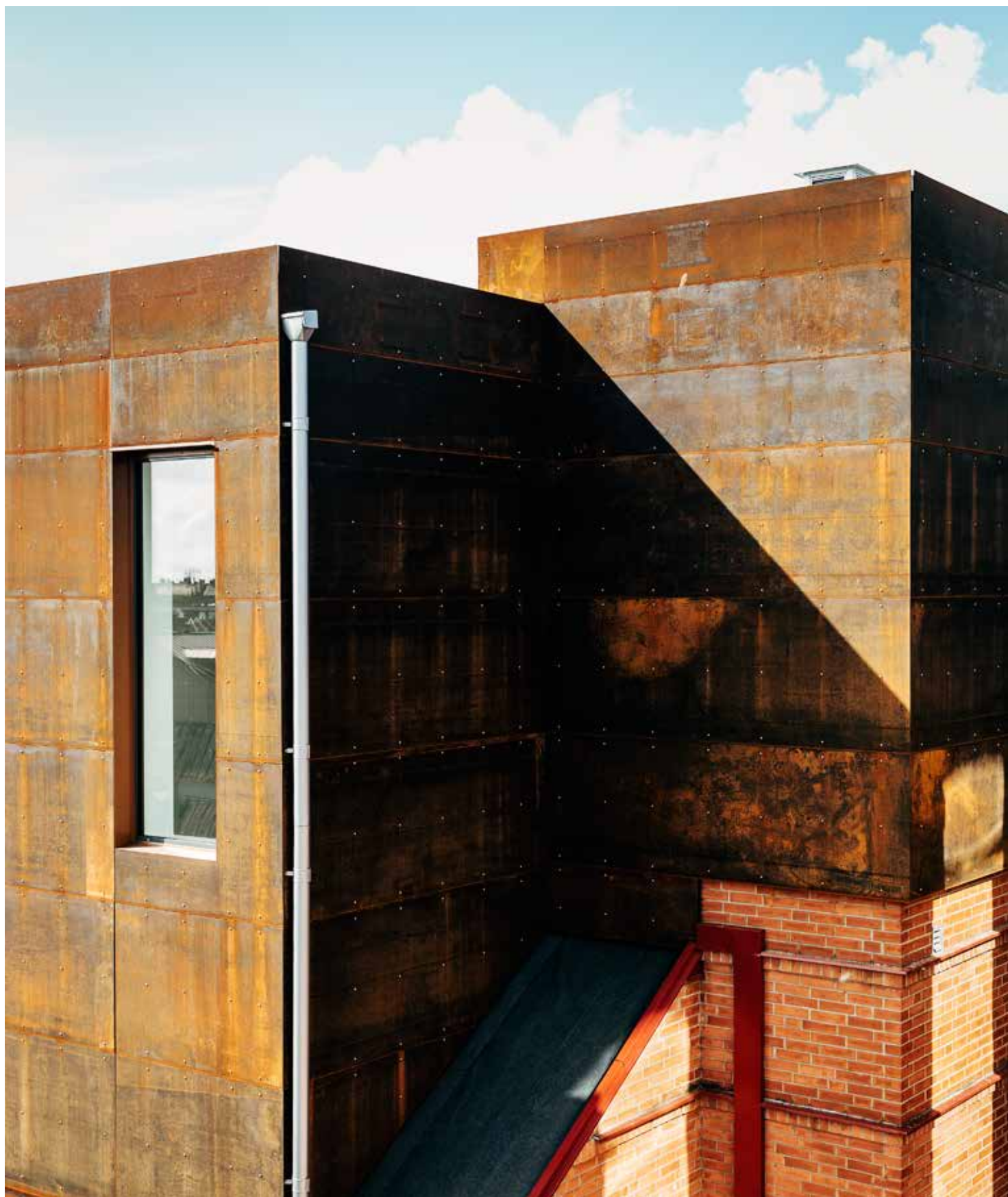
Under 2015 gjordes en spännande tillbyggnad på Armaturen 4 i Lunds centrum när 1100 m 2 toppmoderna kontorslokaler byggdes till på taket.
