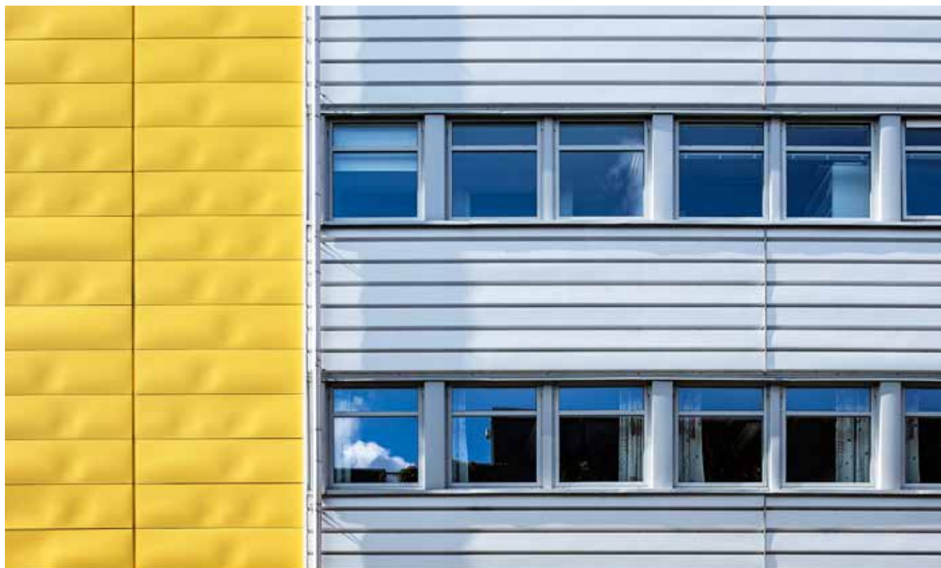
Gul plåt livar upp fasaden på Delta 6 i Lund.
