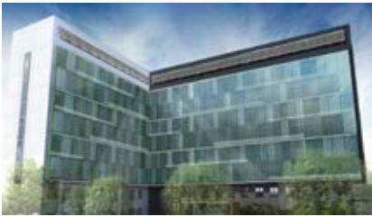
3. HÄKTET SOLLENTUNA Fastighetsbeteckning: Tabellen 4 Byggt/ombyggt: 2010 Lokalarea: 19 070 kvm Hyresgäster: Kriminalvården
