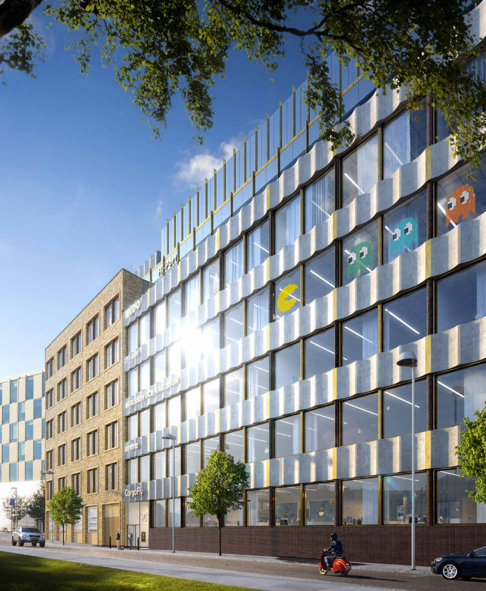
Fastigheten Postterminalen 1 i Lund består av två olika huskroppar; Posthornet och Frimärket. Namnen har inspirerat fasadernas form, ritade av arkitekt Charlotte Von Brömssen på Tengbom.
