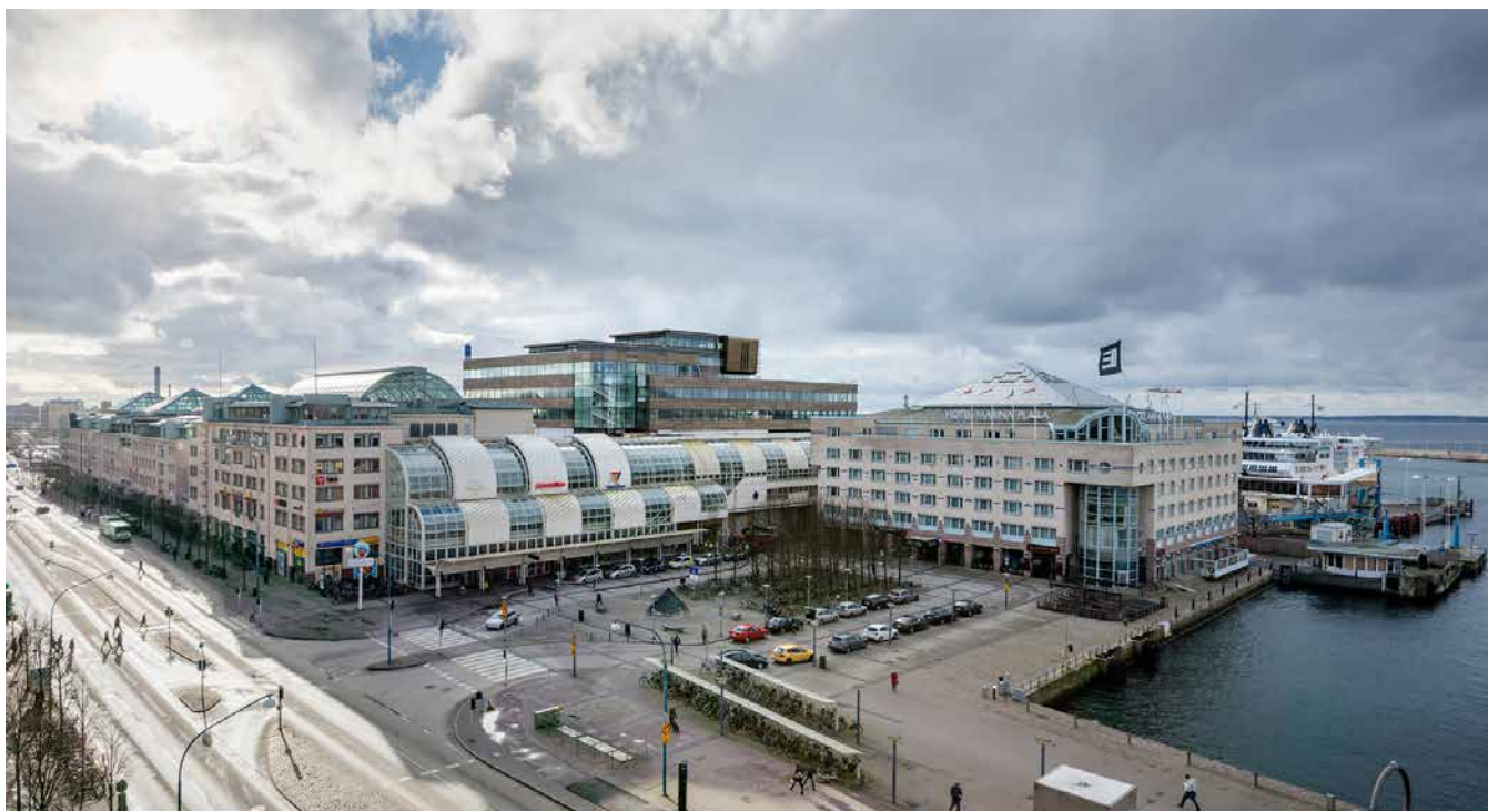
I Helsingborgs hamn reser sig vår nya tillbyggnad på Knutpunkten. Om- och tillbyggnaden är fullt uthyrd och till sommaren flyttar vårt Helsingborgskontor in.
